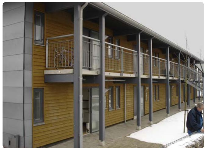
ill. 1.1.2 Nye kollegier er ofte opbygget som almindelige lejlighedskomplekser
